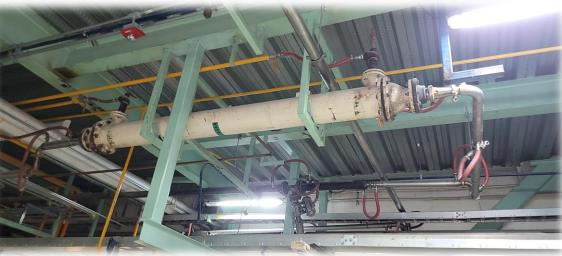
Función: Almacenar en tanque de dia y romper los cristales (Descristalizador).
